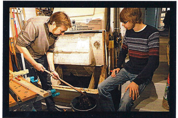
Testfall eins: In der Hamburger Ökosiedlung Allermöhe plumpsen Festes, Flüssiges und Papier vom Trockenklo in ein Kompostgefäß im Keller
